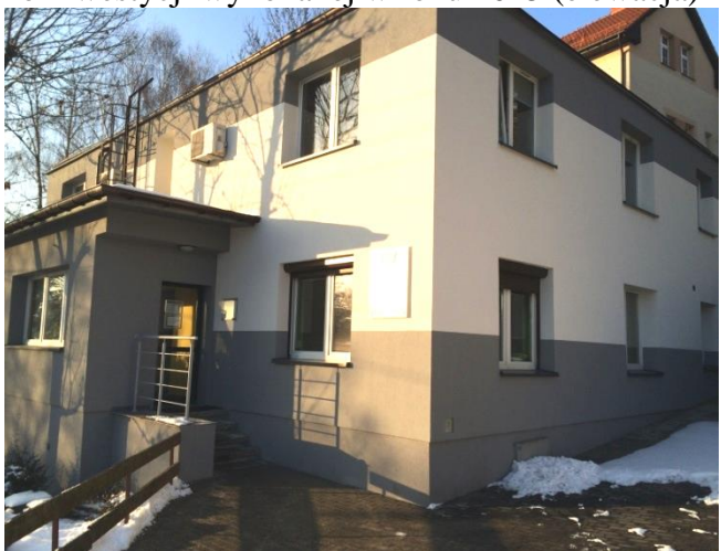
Po inwestycji wykonanej w roku 2015 (elewacja)
