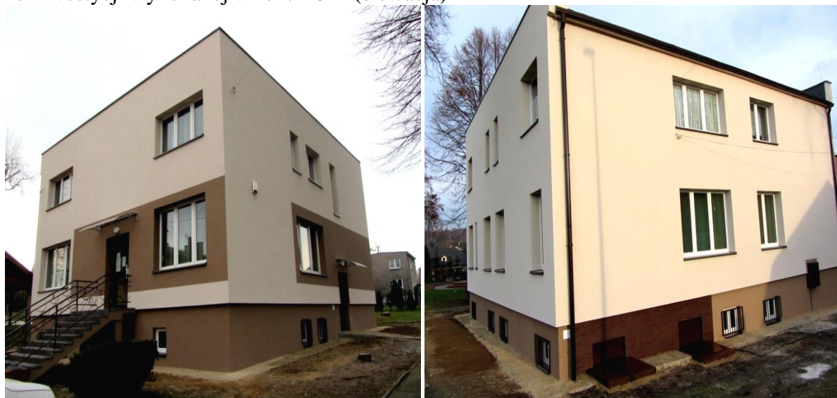
Po inwestycji wykonanej w roku 2014 (elewacja)
