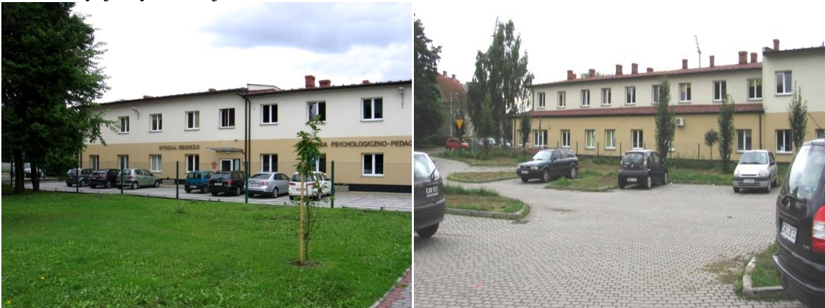
Po inwestycji wykonanej w roku 2009
